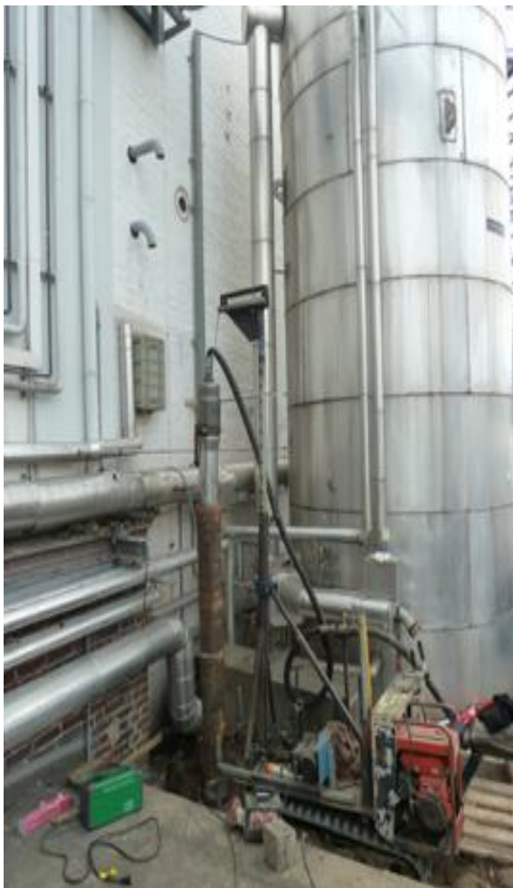
Maschine zwischen Silos und Leitungsführung bei der Pfahlherstellung
