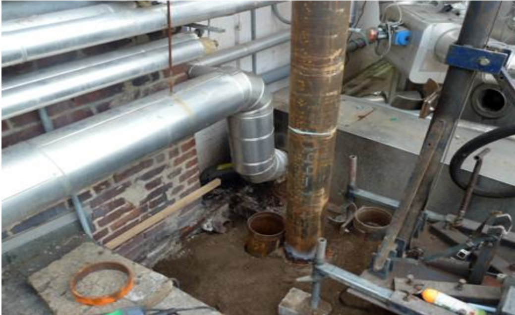
Arbeiten direkt am Bestand, lichter Abstand zur vorhandenen Leitung < 10 cm
