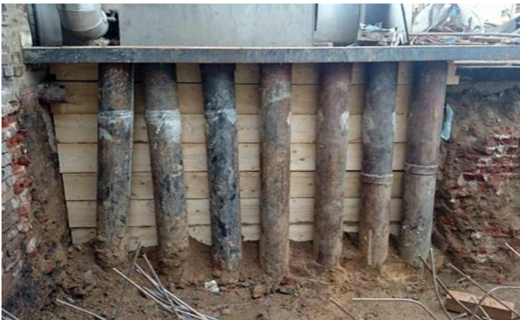
Fertige und aufgelöste Pfahlwand inkl. Kopfgurtung, der linke Pfahl ist auf Grund des geringen Abstandes zur darüber liegenden Leitung zum Bestand als Schrägpfahl ausgeführt worden.
