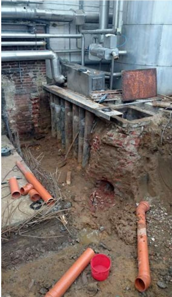
Fertige Pfahlwand zwischen Bestandswand und vorgefundenen Abwasserschacht
