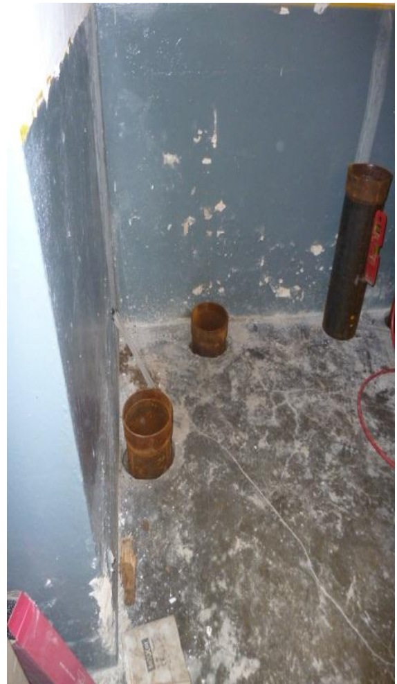
Eingebaute Presspfähle
